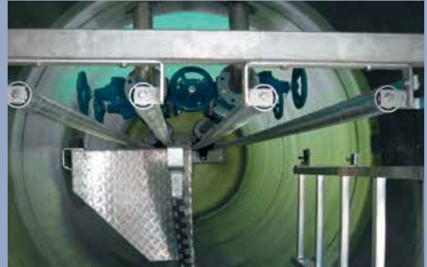
İki ayrı basma basıncı borusu bulunduran özel tasarım boru yapısı
